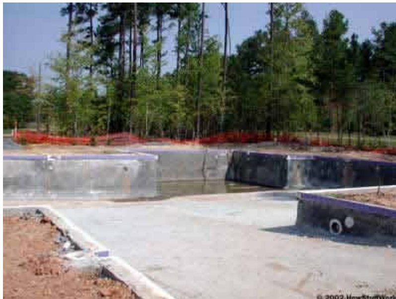
Um complexo de piscinas sob construção: parece um grande buraco no chão, mas é muito mais do que isso
