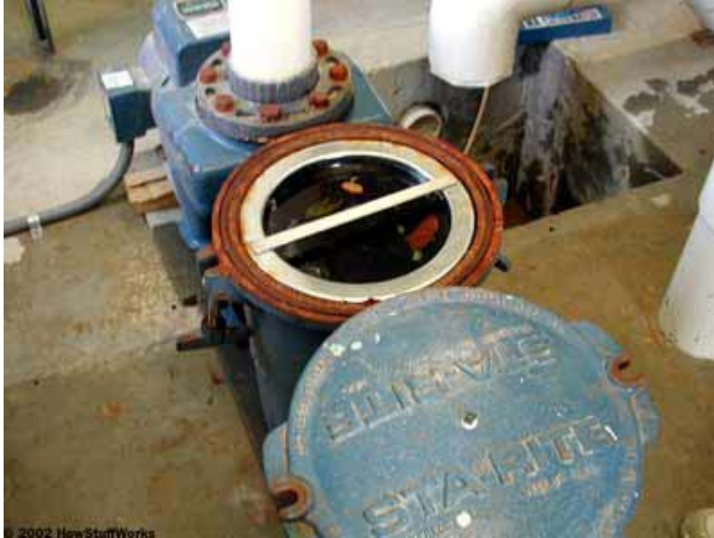
A peneira fica bem à frente da bomba
